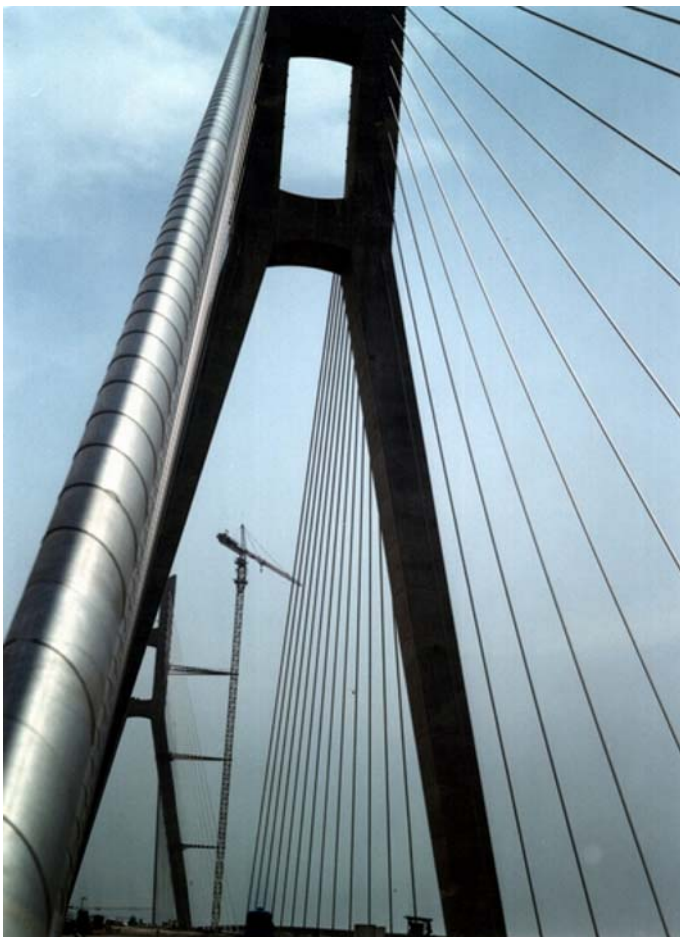
NOCX pipe silver on Run Yang Bridge, China
