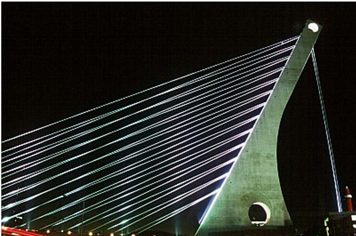
NOCX pipe white incl. ext spiral on Puente la Unidad, Monterrey, Mexico
