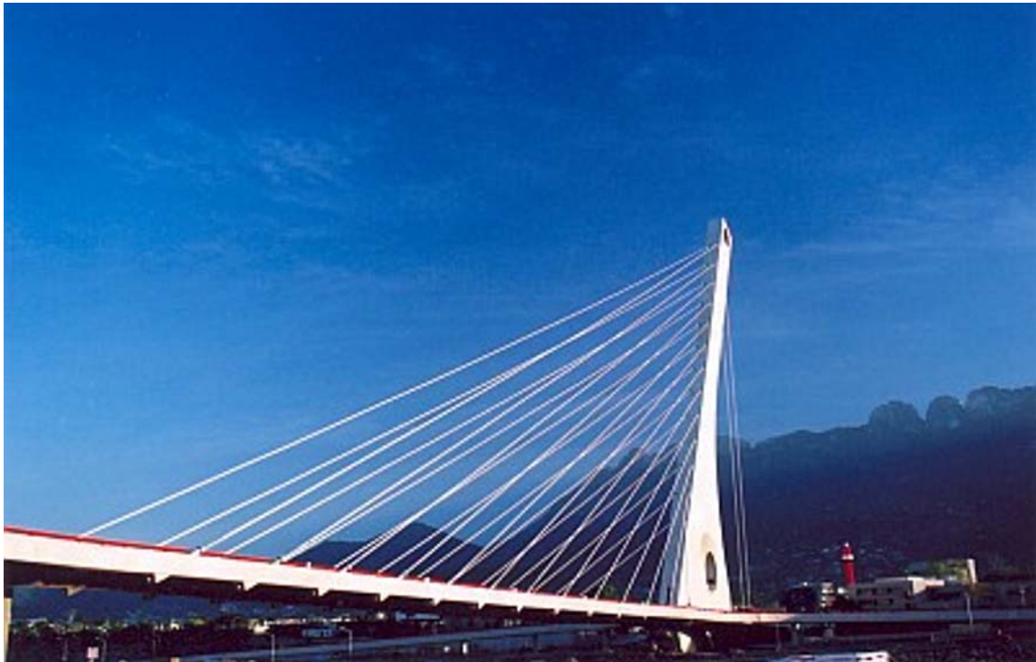
NOCX pipe white incl. ext spiral on Puente la Unidad, Monterrey, Mexico
