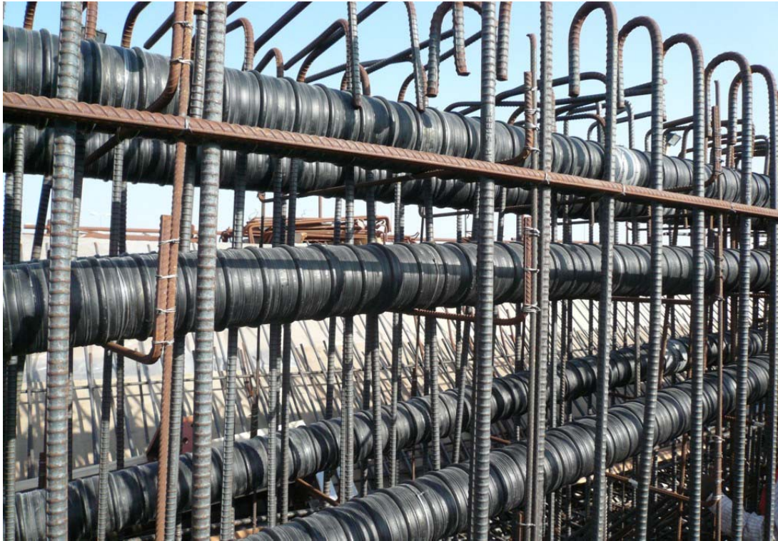
IP 4 M PE Duct on Zallaq Bridge, Bahrain
