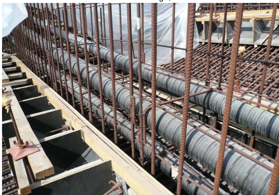
IP 4 M PE Duct installation
